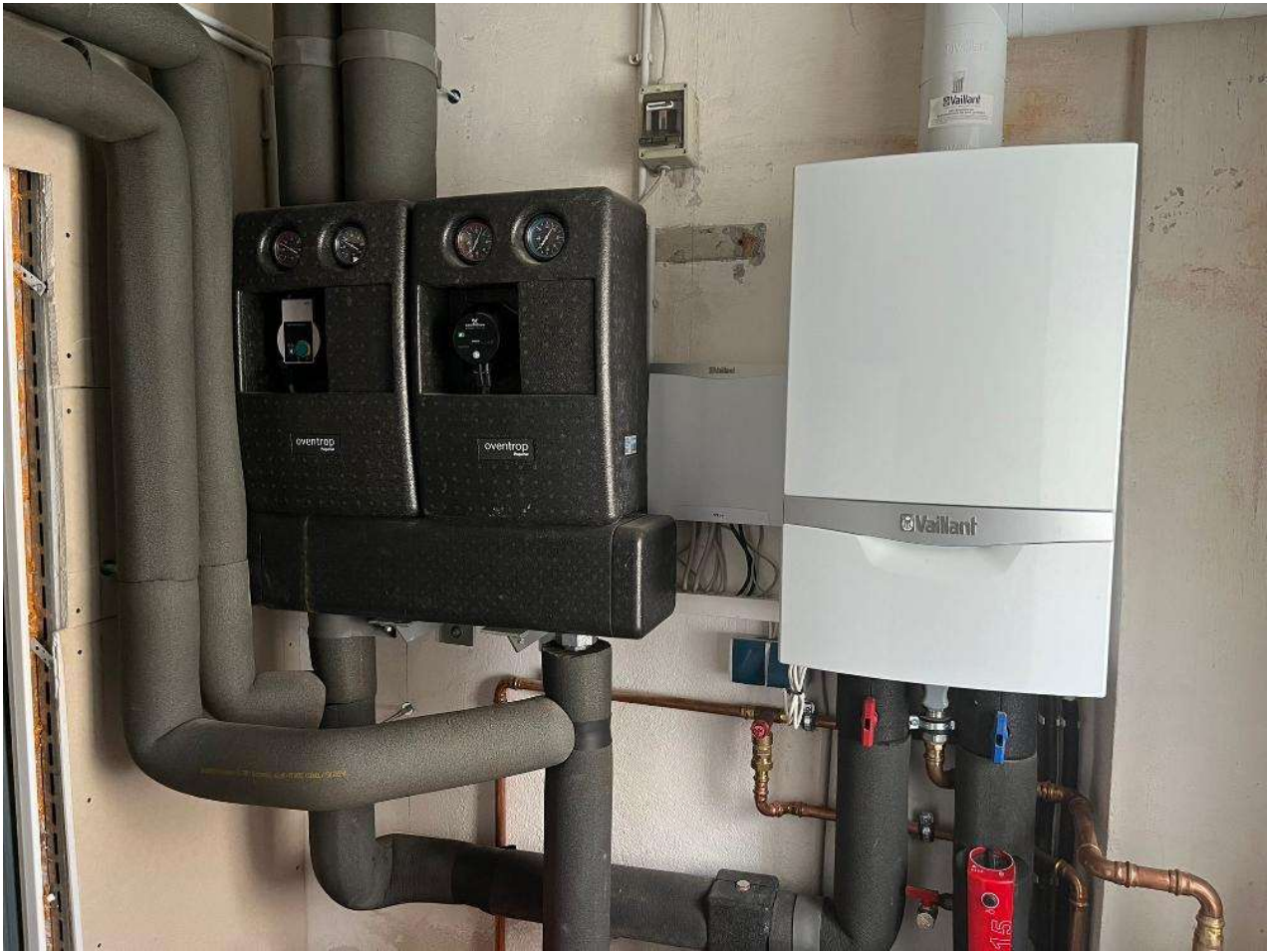
neue Gasbrennwerttherme
